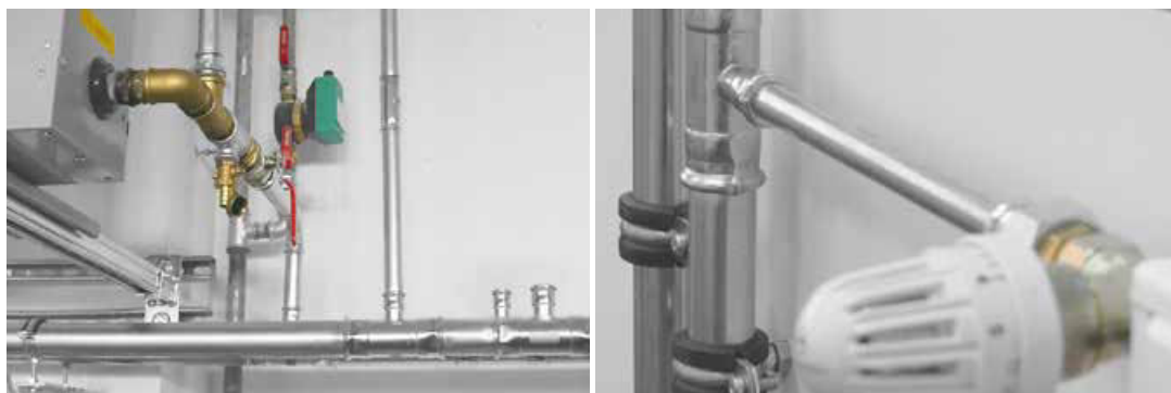
Exemple de instalații KAN-therm Steel
